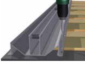
Vertikalschiene montieren
